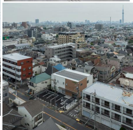
屋上太陽光パネル設置
